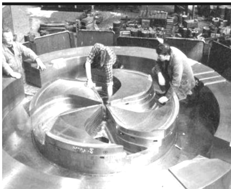
Рис. 32. Фотография полюсов магнита протонного циклотрона С 235 компании Ion Beam Application на энергию 235 МэВ.
